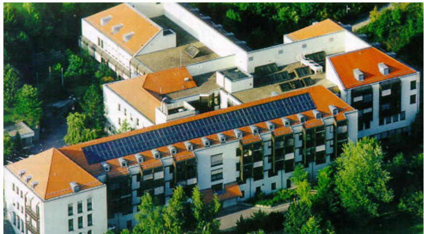
Abbildung 1: Krankenhaus Burglengenfeld mit Solarkollektoranlage auf dem Haupthaus (Quelle: Krankenhaus Burglengenfeld)
