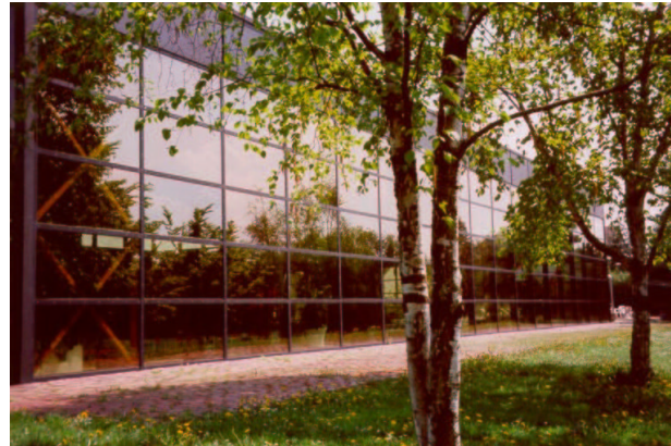
Abbildung 1: Fassade Hallenbad Neutraubling
